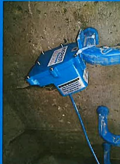
Création de chambre avec installation de sonde et de boîtier émetteur pour permettre de connaître le débit de fuites du côté du lieu dit "Sous le pas" jusqu'au lieu dit "Les Portes".
